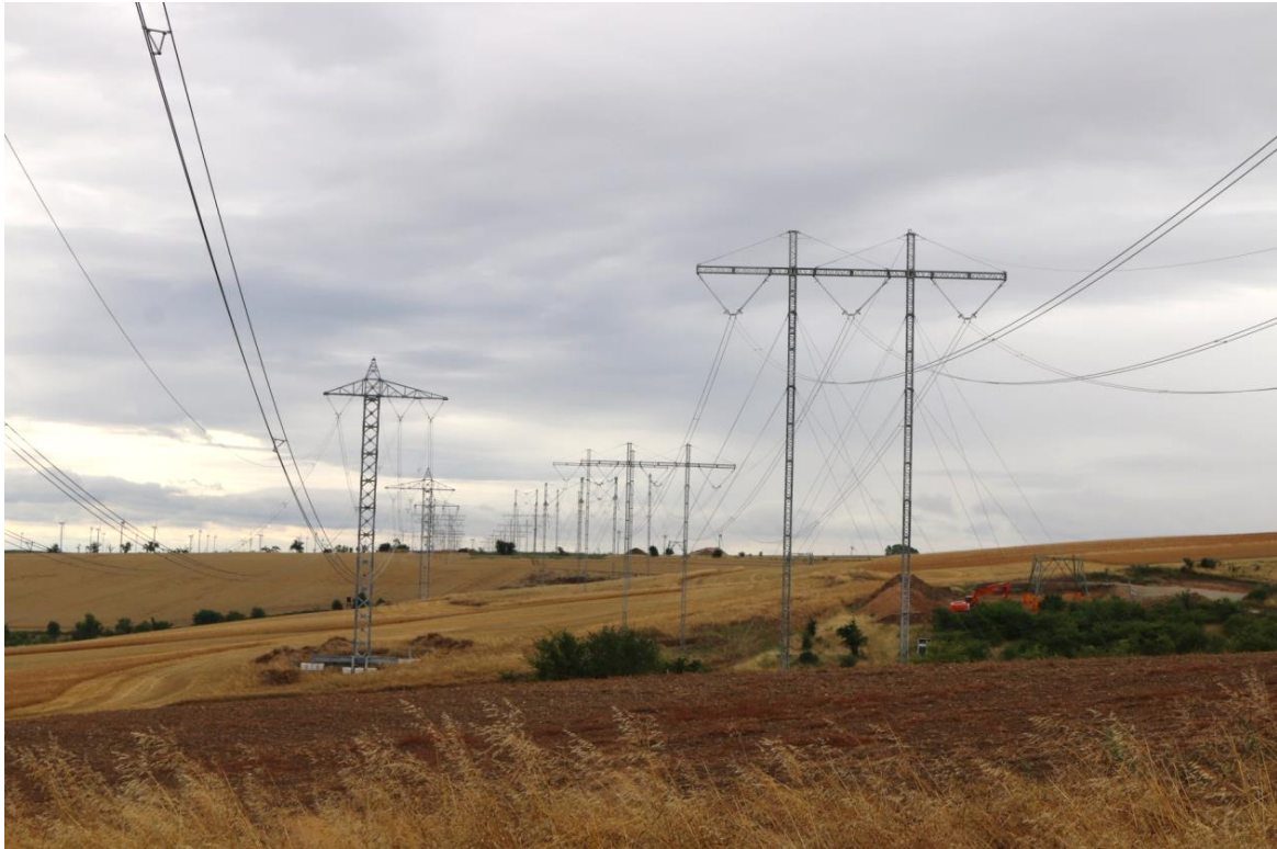
Abbildung 13: 380-kV-Freileitungsprovisorium für zwei 380-kV-Stromkreise
